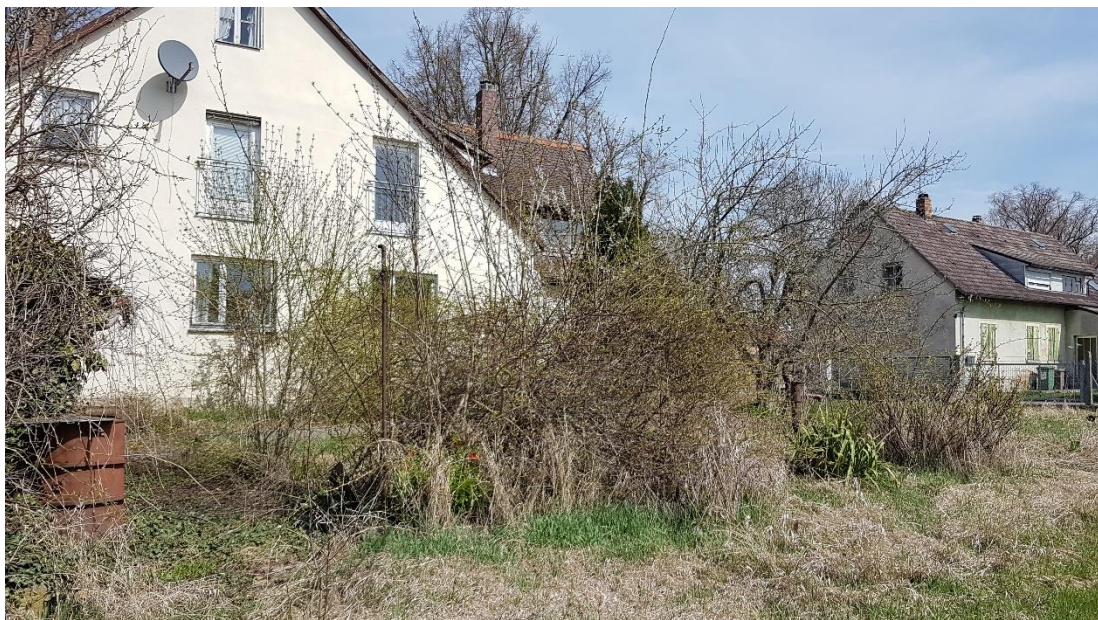
Abbildung 3: Blick auf das ehemalige Wohnhaus in der nordöstlichen Grundstücksecke.
