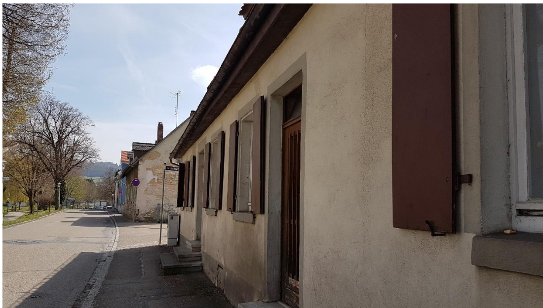
Abbildung 12: Das nicht mehr bewohnte Gebäude grenzt im Norden des Grundstücks an die Südliche Ringstraße.
