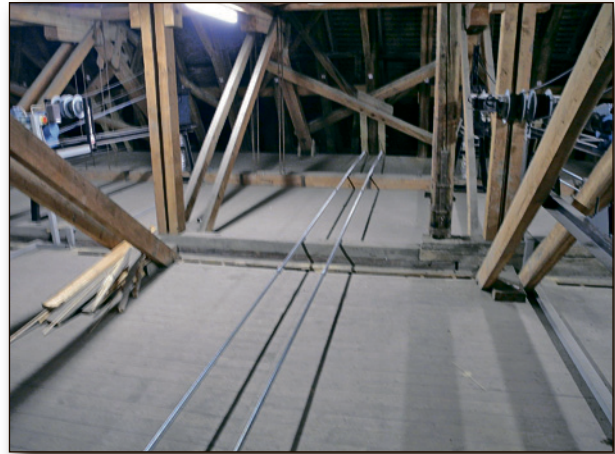
Abb. 2: Zusätzlich eingebrachte Zugbänder aus Edelstahl-Gewindestangen.
