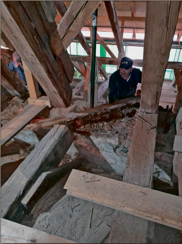
Abb. 3: Ausbau der beschädigten Mauerschwellen.
