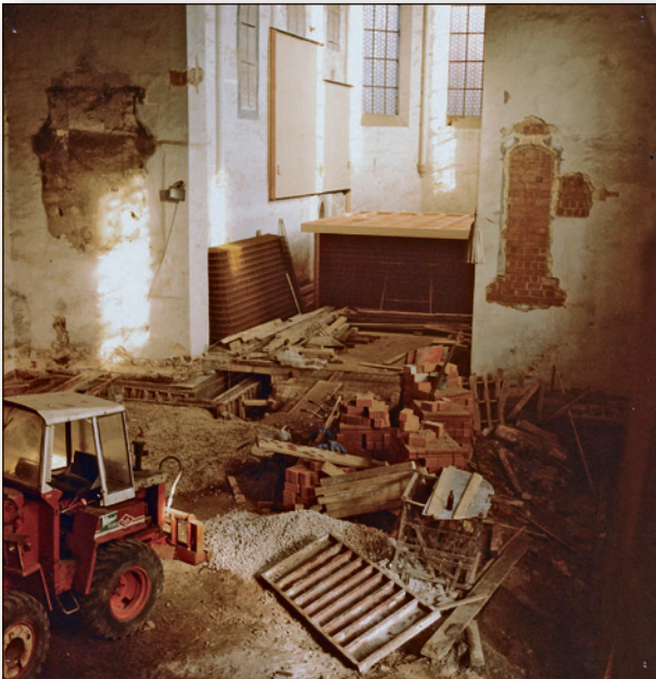
Abb. 6: Entkernung des Kirchenraums beim Umbau (1981-1983).
