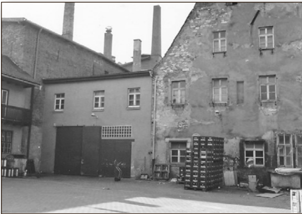
Abb. 14: Blick vom Brauereihof auf den Klosterflügel (rechts) und den inzwischen abgebrochenen Anbau (links), 1992.
