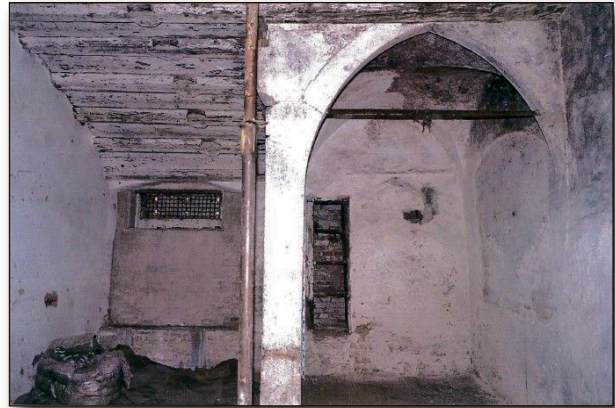
Abb. 3: Gewölbte Balken-Bohlen-Decke mit später eingestellter Ofenstelle, 2019 (Foto: I. Winklmann).
