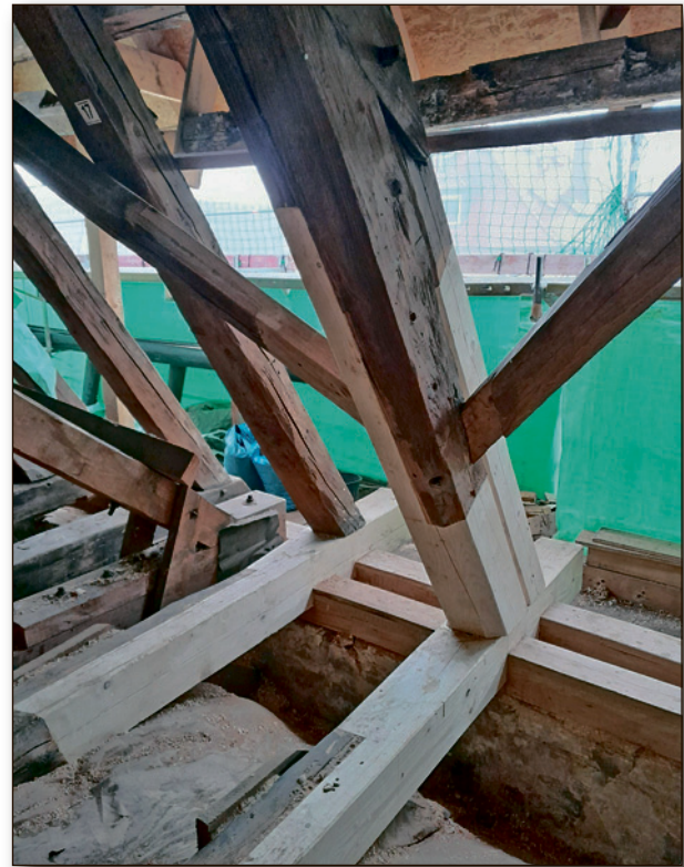
Abb. 4: Ergänzte Mauerschwellen, Deckenbalkenköpfe und Sparren.
