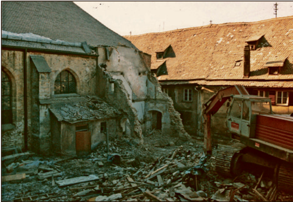
Abb. 4: Abbruch der beiden kleineren Klosterflügel im Februar 1981.
